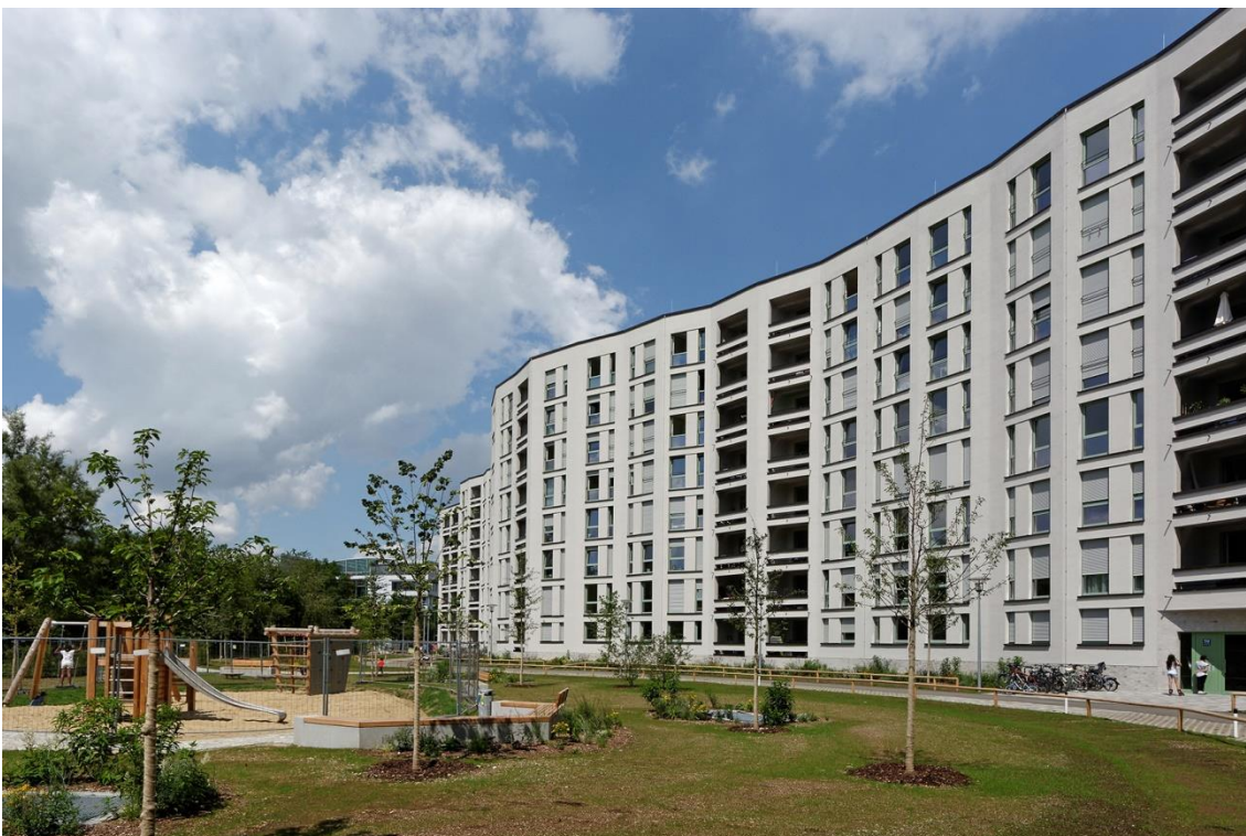
Das erste und bereits bezogene der beiden geschwungenen Gebäude (Foto: Roland Weegen)
