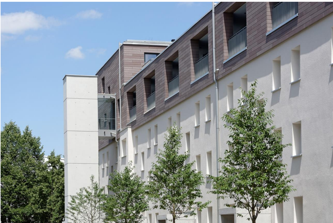
Gebäude-Aufstockung in der GEWOFAG-Siedlung Sendling (Foto: Roland Weegen)
