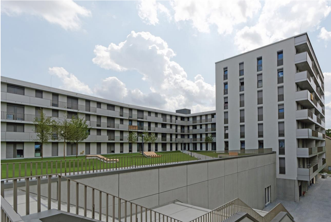
Der ruhige Innenhof des GEWOFAG-Pilotprojekts Azubiwohnen am Innsbrucker Ring (Foto: R. Weegen)
