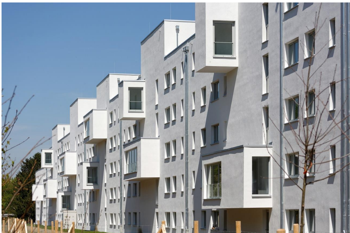
Die Schallschutzseite des Gebäuderiegels zur Autobahn auf der Westseite (Foto: Roland Weegen)
