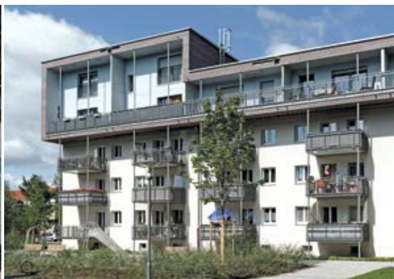
Gebäude-Aufstockung in der GEWOFAG-Siedlung Sendling
