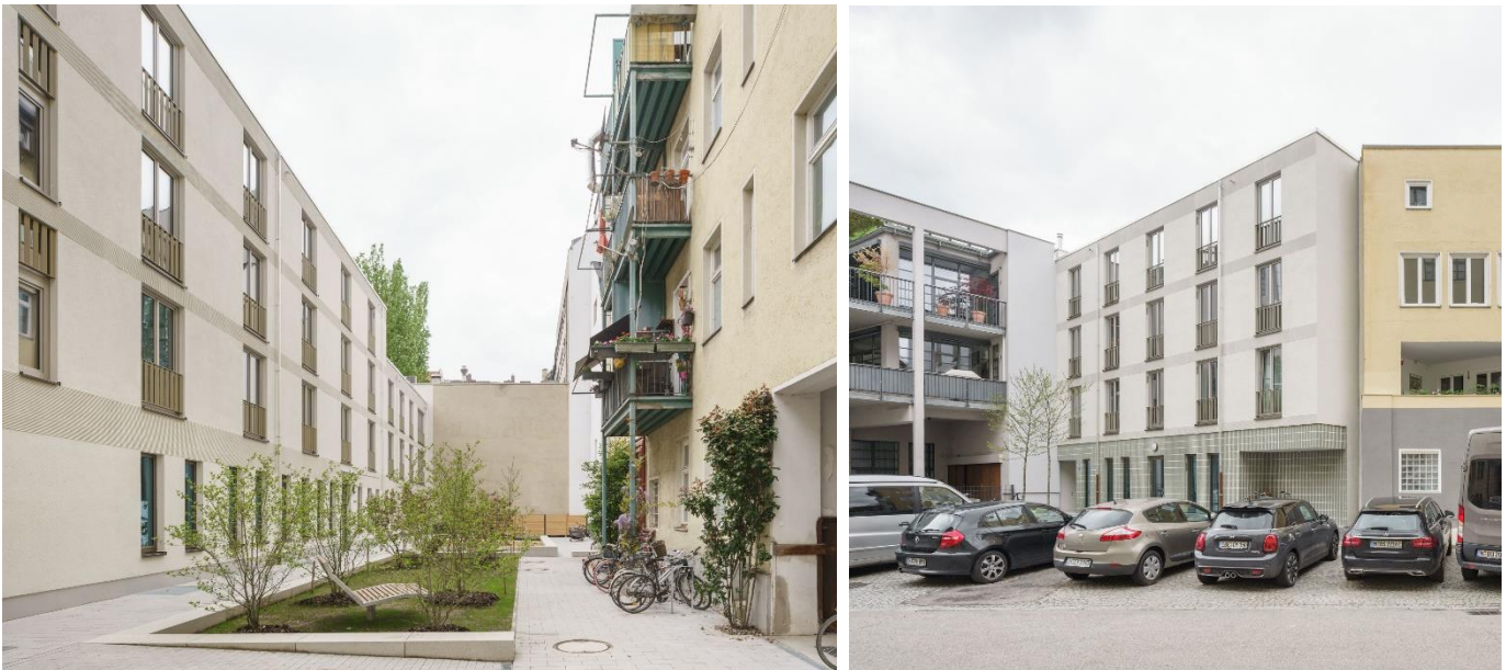
Der Neubau teilt sich nun den neu gestalteten Innenhof mit den Altbauten zur Thierschstraße hin (links). Die Lücke zur Liebherrstraße wurde geschlossen (rechts).
