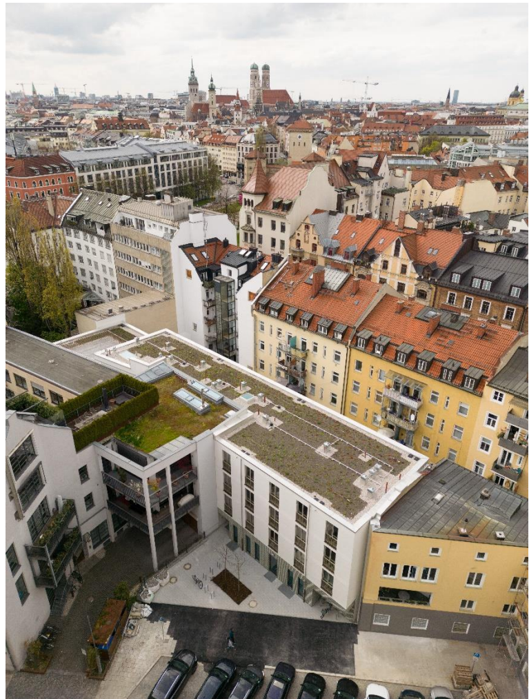
Beste Lage, komplizierte Baustelle: Das Drohnfoto zeigt, auf welchem beengtem Raum das neue Gebäude (im Vordergrund) entstanden ist.
